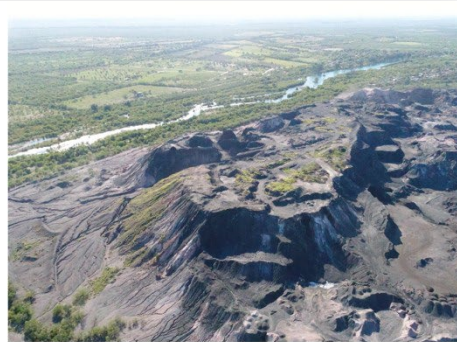
Nueva Rosita. Pasivo colindante con el Río Sabinas
